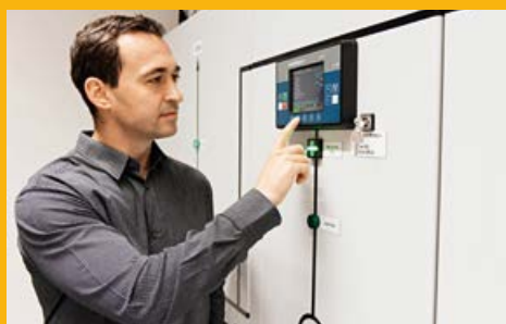
VYUŽITÍ ZBYTKOVÉHO TEPLA Z DATOVÉHO CENTRA K VYTÁPĚNÍ KANCELÁŘÍ VODAFONE CZECH REPUBLIC
